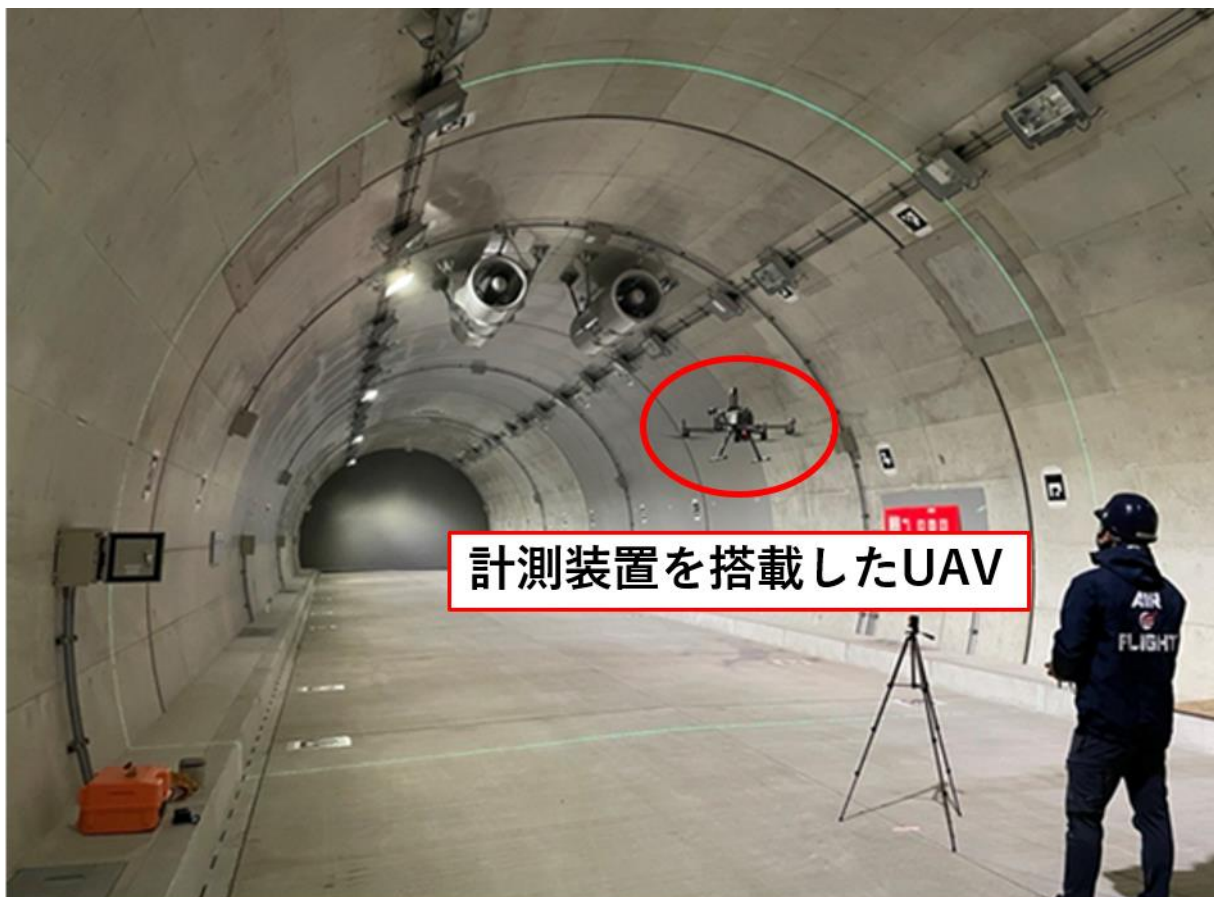
写真4 UAVによるトンネル断面の計測状況
