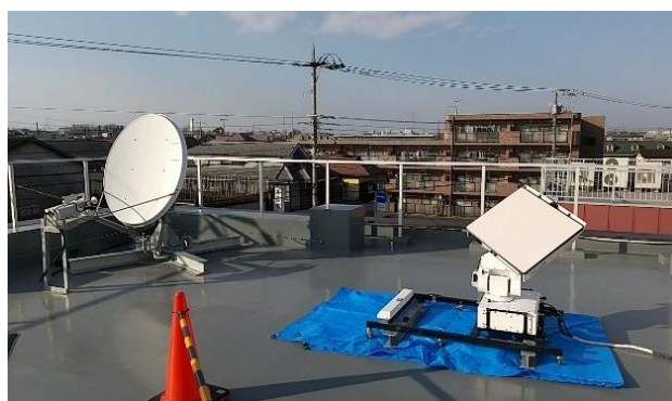
図 2 : Gateway 局、VSAT 局
